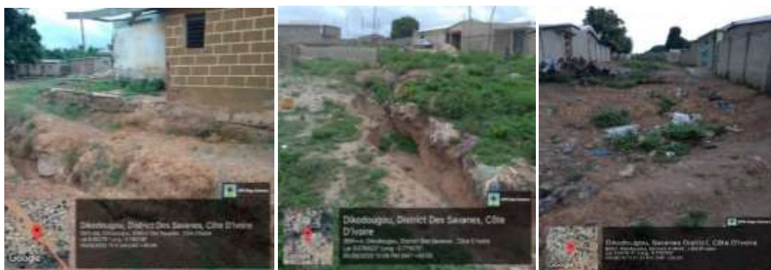
Planche 1 : Rues et bâtis dégradés à Dikodougou du fait de l'érosion
